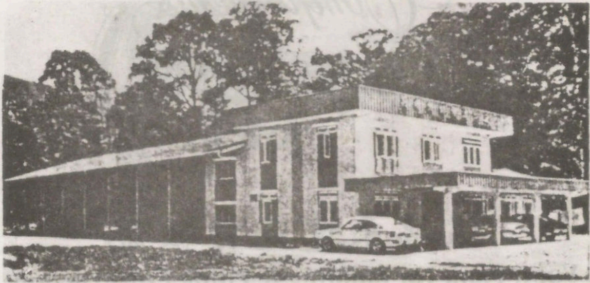
倫樂坡新工廠全貌
